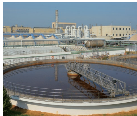
天方药业污水处理池
